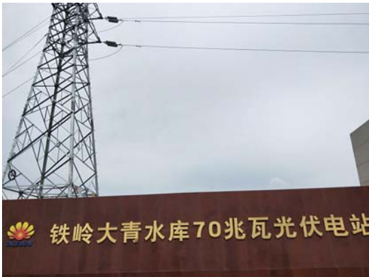
升压站建设完成
