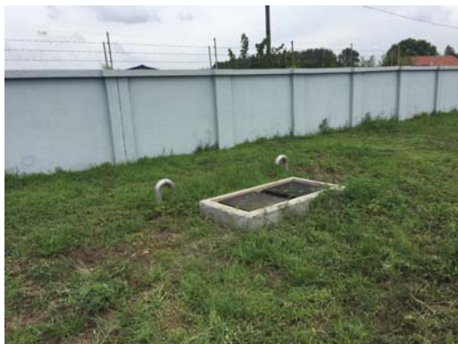
升压站事故池
